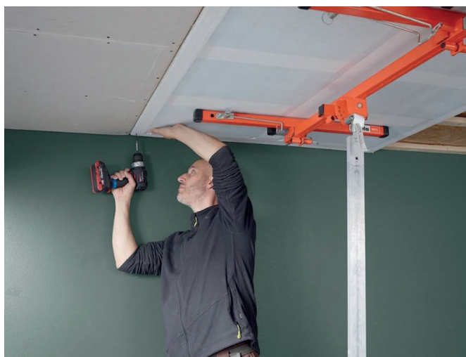
Abbildung 3: Montage der thermoheld Trockenbauplatte 36V an der Decke mit Plattenheber
