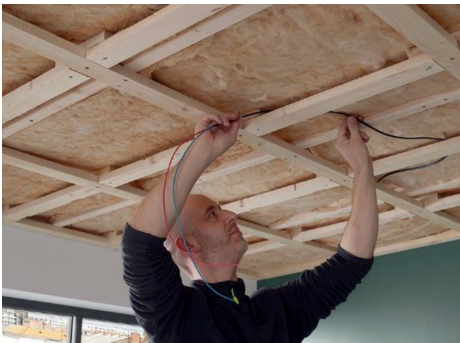
Abbildung 2: Beispiel einer Decken-Unterkonstruktion aus Holz. Die Kabel müssen hier vor Montage der thermoheld Trockenbauplatte 36V verlegt werden.
