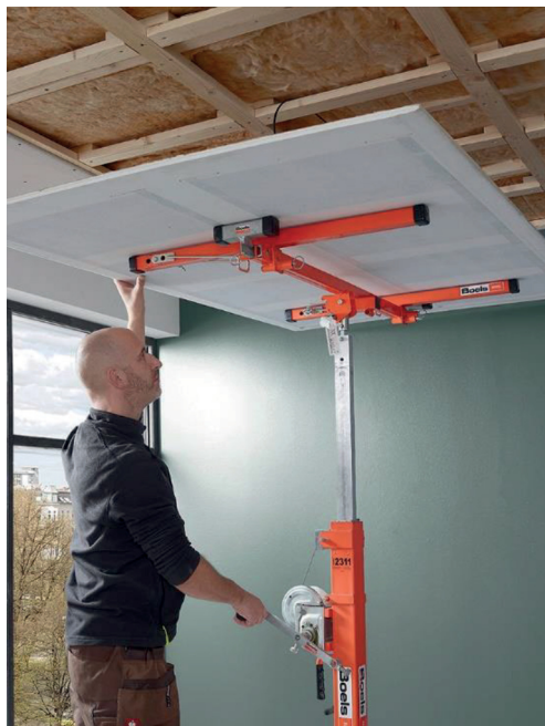
Abbildung 3: Montage der thermoheld Trockenbauplatte 36V an der Decke mit Plattenheber
