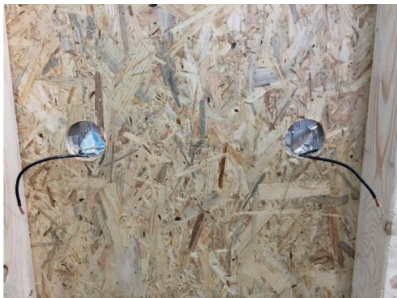
Abbildung 5: Hintere Planke mit Löchern für die Kabeldurchführungen
